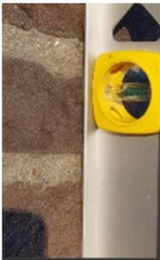
Gemeten vanaf de bovenkant van de tuinmuur
