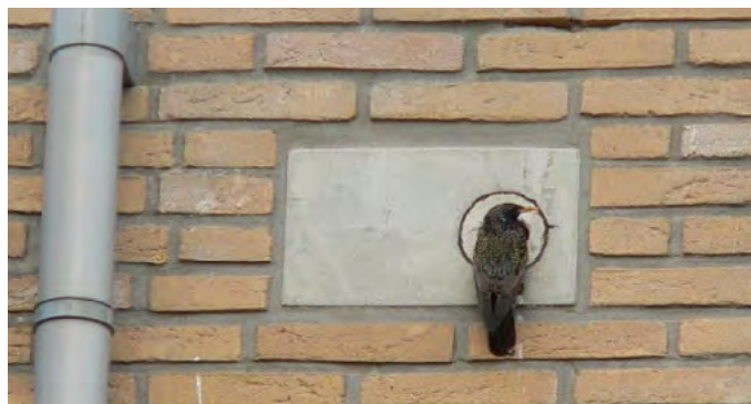
Neststeen in bebouwing ter behoeve van biodiversiteit
