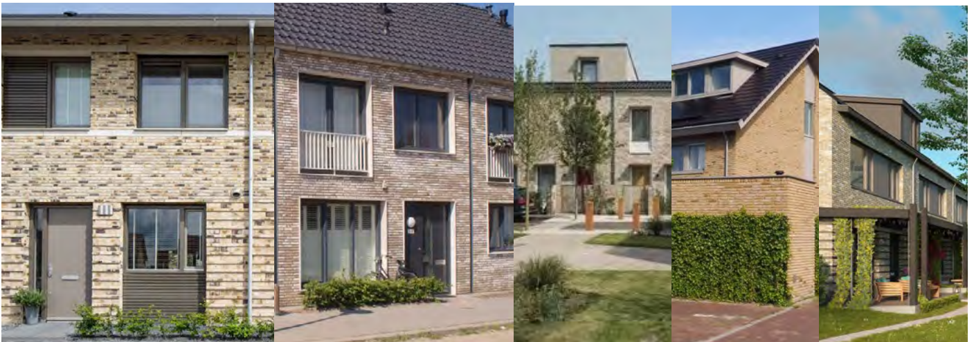
Kozijnen hebben ingetogen kleur. Paneelvulling bij ramen gelijk aan kozijn, met textuur of volledig uit baksteen.
