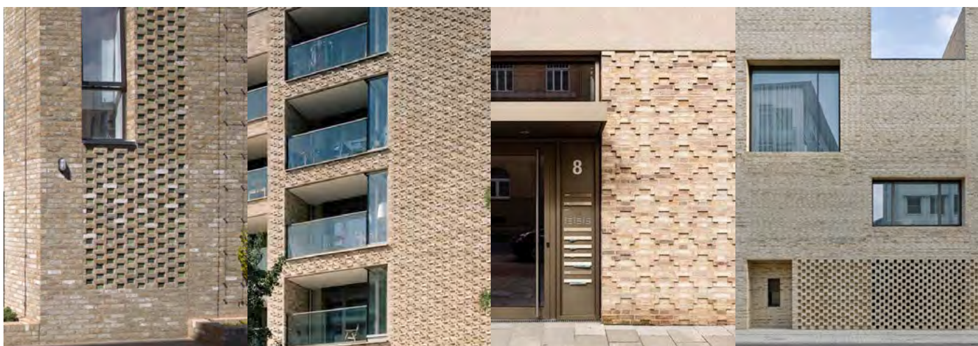
Bergingen translucentie, opengewerkte baksteen of textuur in metselwerk om gesloten vlak te doorbreken, voorkeur met raam ter hoogte van gang.
