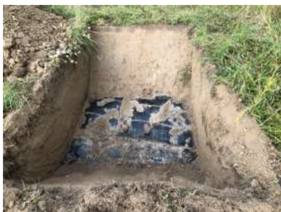
Foto 3: gegraven inspectiesleuf
