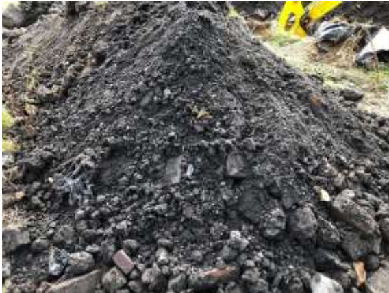
Foto 7: overzicht ontgraven stortmateriaal
