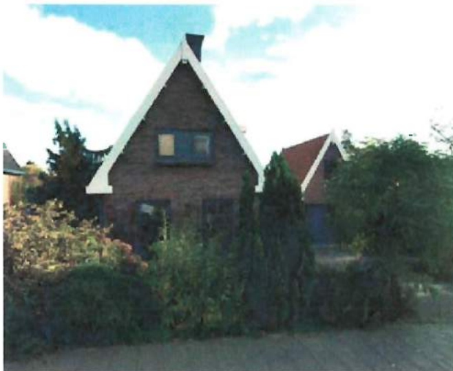
Groene voorgrond, bijgebouw afgestemd op het hoofdgebouw
