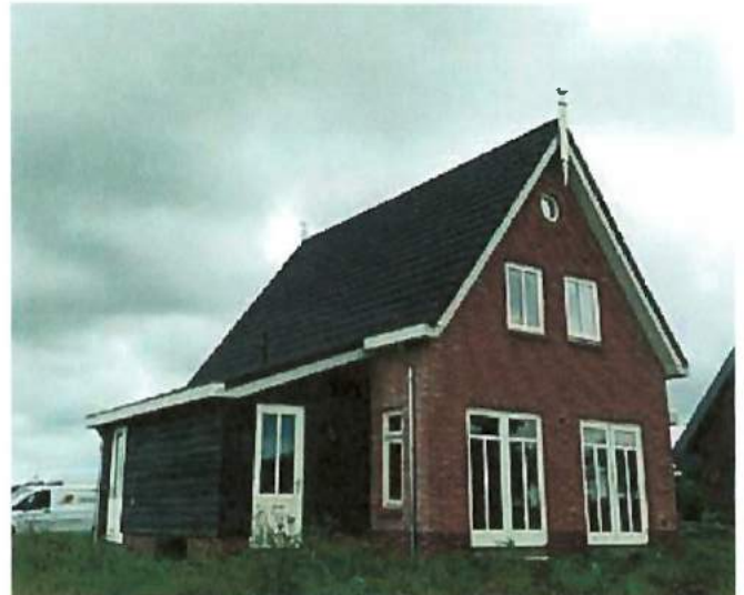
Hoofdvorm eenvoudig, baksteen in rode kleur. Bijgebouw kleinschalig en in afwijkend materiaal: zwart gepotdekseld hout,
