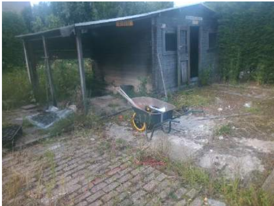
Foto 3: Locatie voormalige tank.
