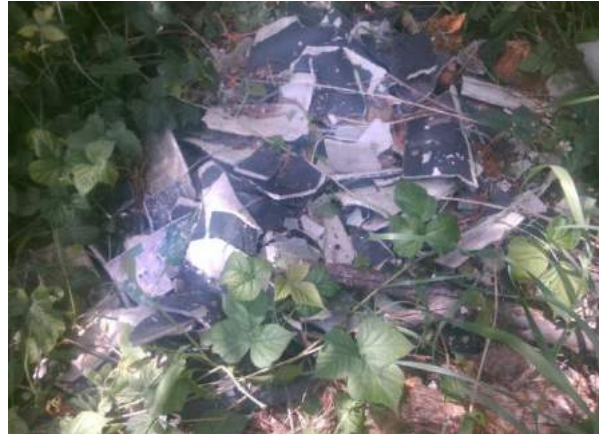
Foto 6: aangetroffen plaatmaterialen op het maaiveld
