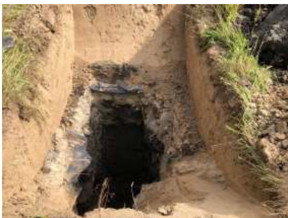
Foto 5: gegraven inspectiesleuf
