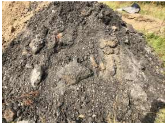
Foto 12: overzicht ontgraven stortmateriaal
