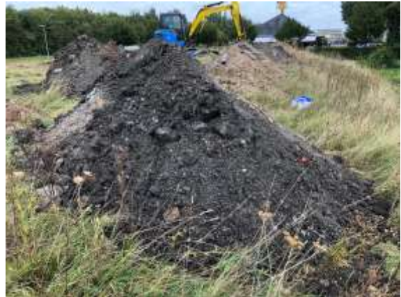
Foto 10: overzicht ontgraven stortmateriaal
