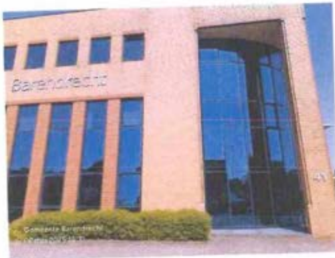
Foto 5 1e verdieping gordijnen te zien van eerdere controle d.d. 25 april 2025
