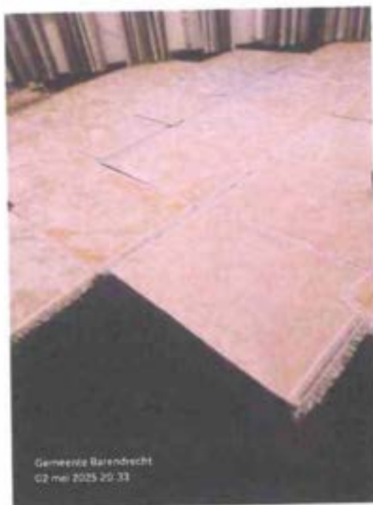
Foto 12 Lezing en gebedsruimte heren 1e verdieping
