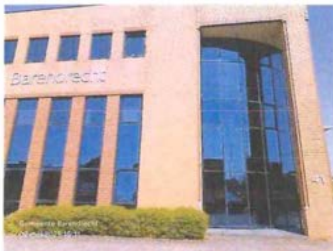
Foto 5 1e verdieping gordijnen te zien van eerdere controle d.d. 25 april 2025
