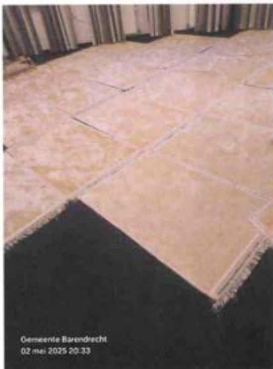
Foto 12 Lezing en gebedsruimte heren 1e verdieping
