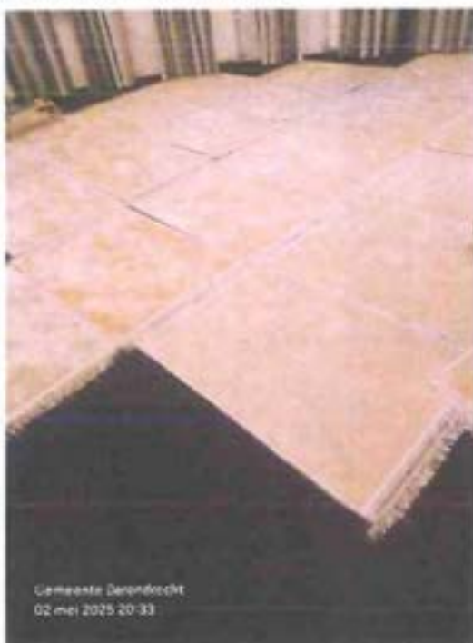
Foto 12 Lezing en gebedsruimte heren 1e verdieping
